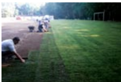
Verlegen des Rollrasens
